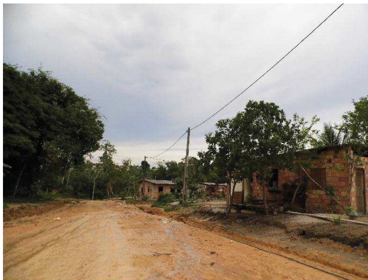
Figura 32: Visão interna do Parque das Tribos. Via ainda não contemplada com o serviço de asfaltamento. (Autor: Amilcar Jimenes, 2019)
