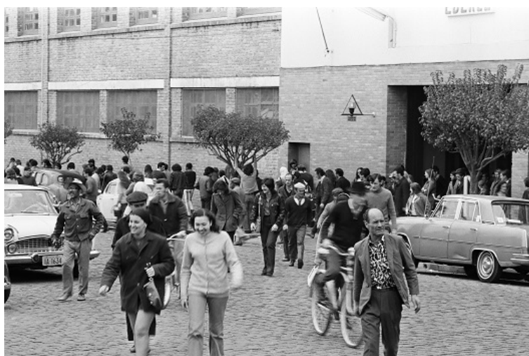
Figura 8 - Saída dos trabalhadores da Maesa pela Rua Plácido de Castro em 1970.
