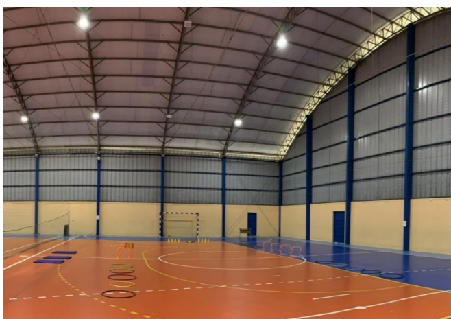
Foto 36: Estação 6 – 6ª Pista – Execução do Circuito
