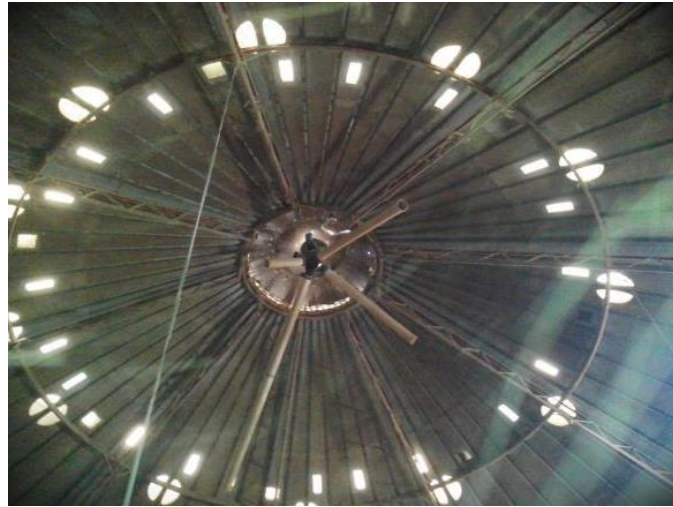
Figura 26 – Distribuidor autopropelido de grãos
