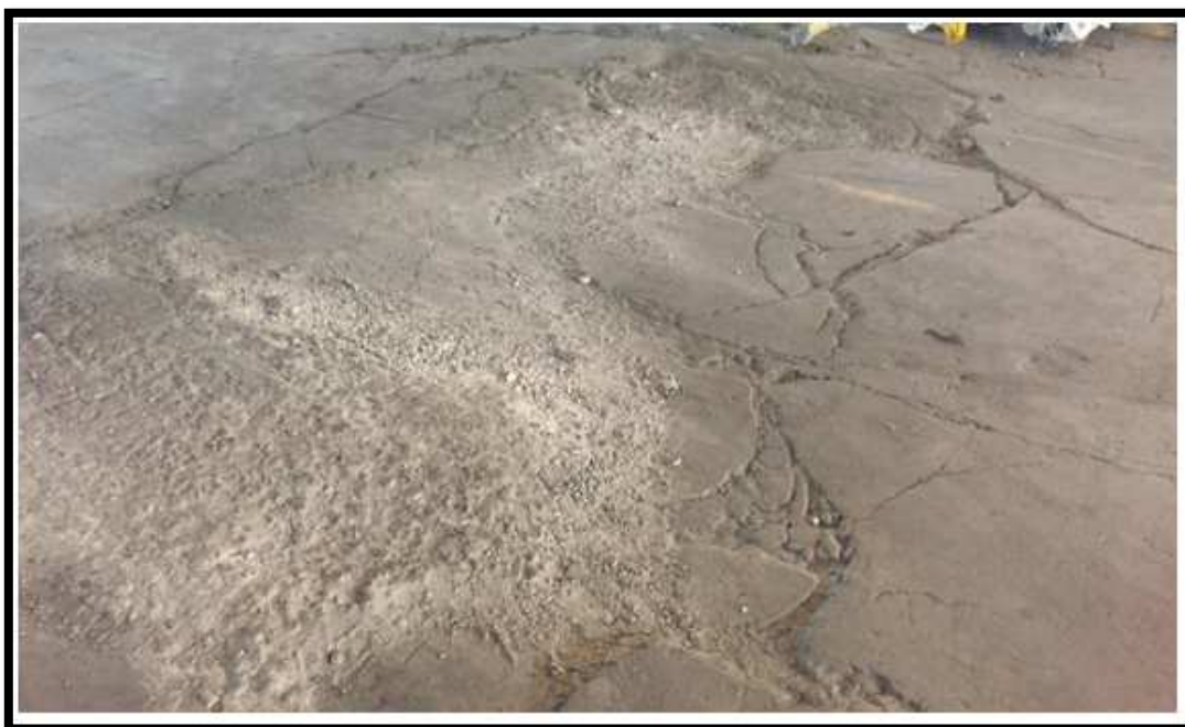
Figura 18 - Piso armazém do porto em destaque
