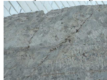
Figura 13 Foto de junta de concretagem
