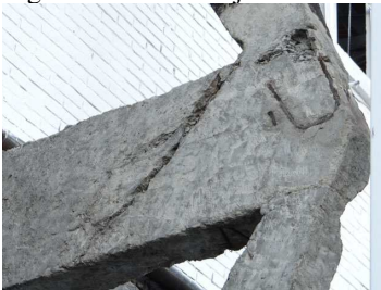
Figura 12 - Foto de junta de concretagem
