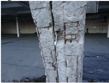
Figura 10 - cobrimento insuficiente
