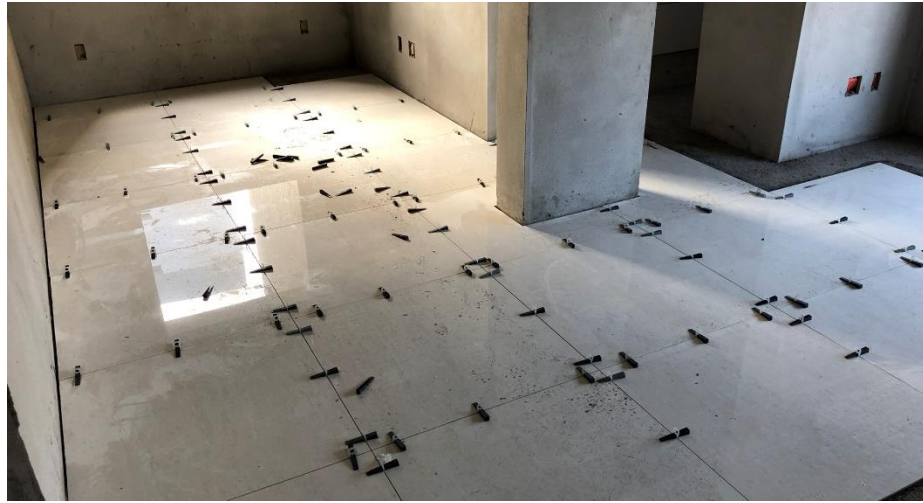
Fotografia 13 – Espaçadores/Niveladores no piso 80x80 cm
