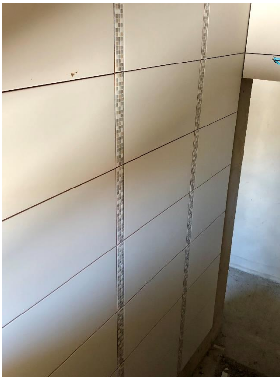
Fotografia 8 – Detalhe Duplo, Ecocement L-200 Multicolor
