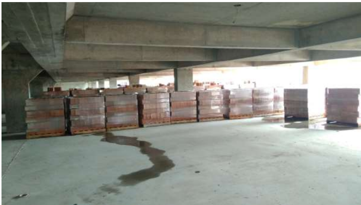
Fotografia 1 – Estoque de blocos cerâmicos 14x19x29 na obra A
