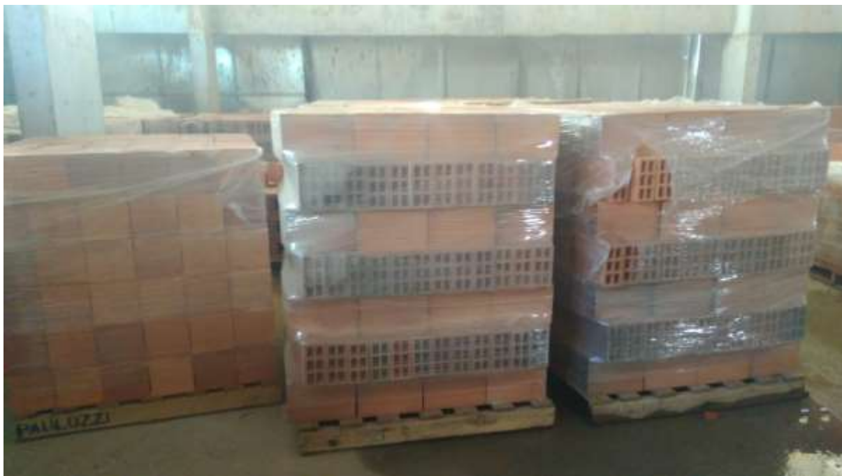
Fotografia 2 – Estoque de blocos cerâmicos 09x19x29 na obra B
