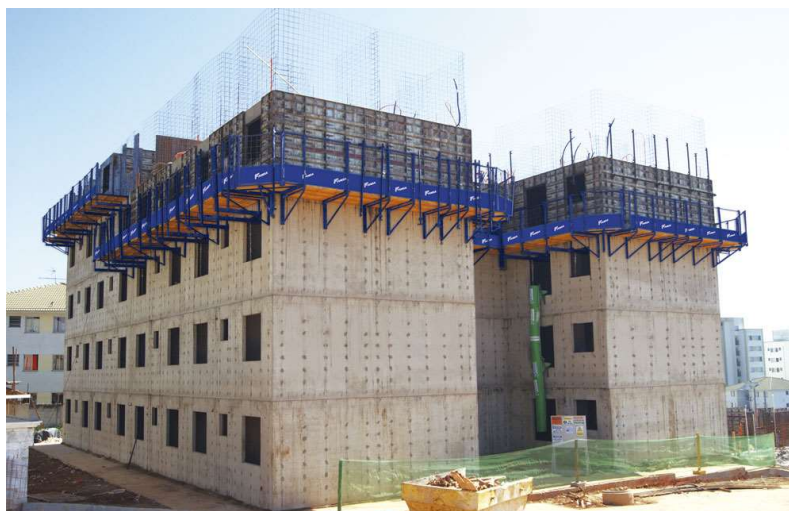
Figura 6 – Montagem de formas metálicas
