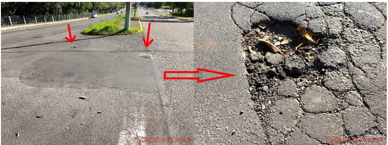
Figura 25 – Fotografia da área de retorno a ser executada como reconstrução
