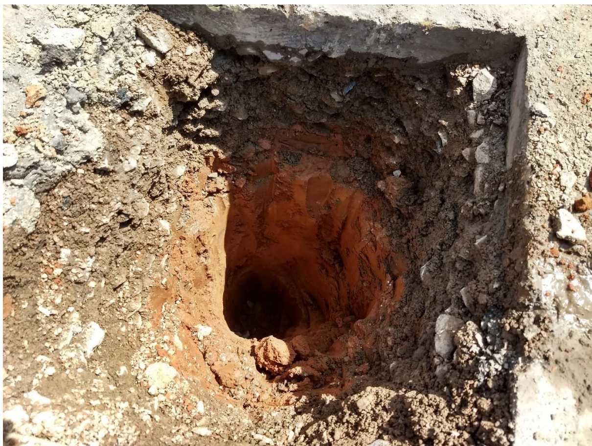
Figura 13 – Abertura de trincheira em pavimento
