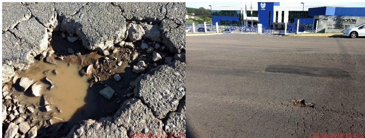
Figura 22 – Identificação de trecho existente com sub-base de brita graduada
