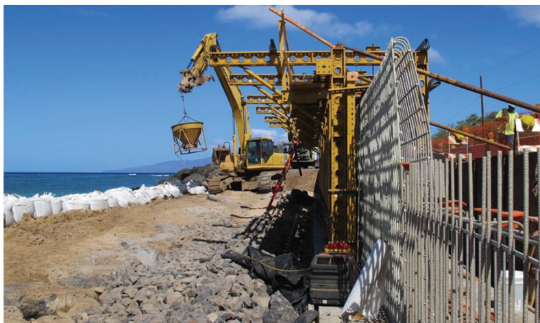
Figura 12 – Muro de proteção de rodovia com barras GFRP - Maui/Havaí
