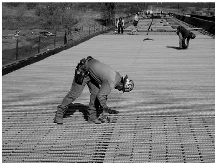
Figura 8 – Instalação de armadura da camada superior de plataforma de ponte em GFRP
