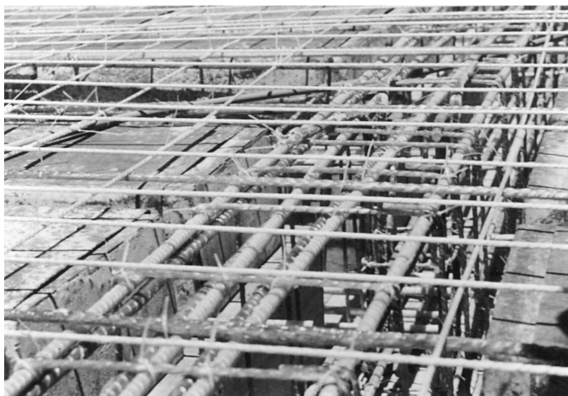
Figura 9 – Construção do edifício hospitalar em San Antonio / Texas
