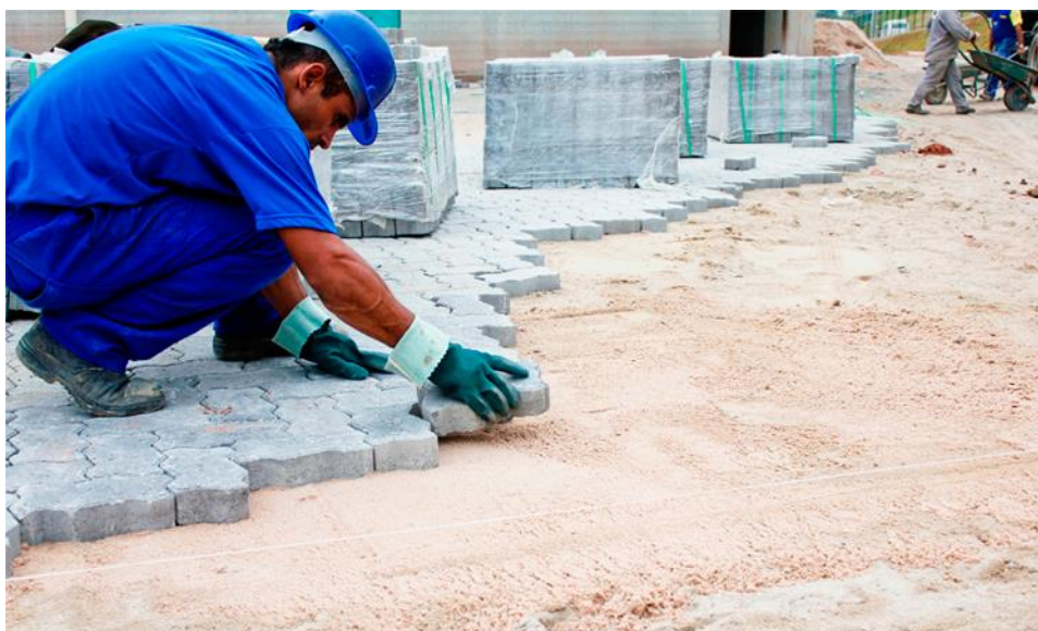
Figura 6 – Assentamento da peça pré-moldada
