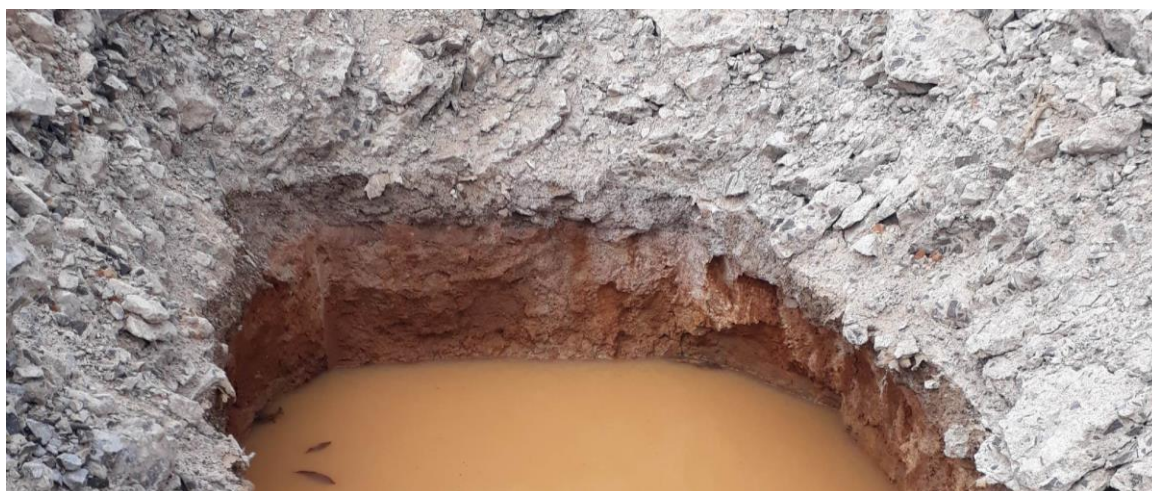
Fotografia 1 – Sub-base em CCR preservada
