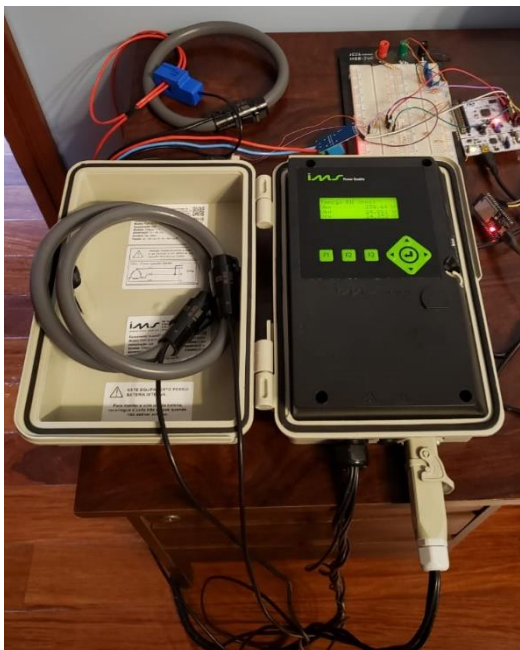
Figura 67 - Analisador de energia e protótipo durante a medição das cargas.
