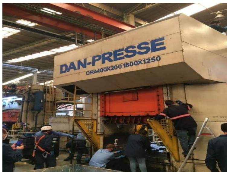
Fotografia 3 – Limpeza e inspeção 1
