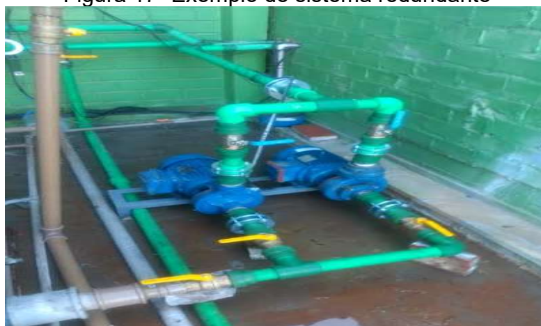
Figura 17- Exemplo de sistema redundante
