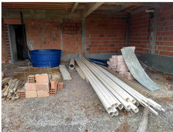
Figura 14 – Materiais diversos estocados no pav. subsolo
