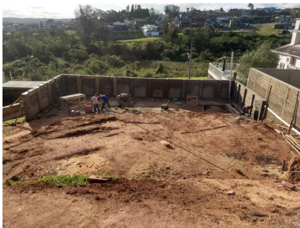
Figura 7 – Execução do muro de contenção
