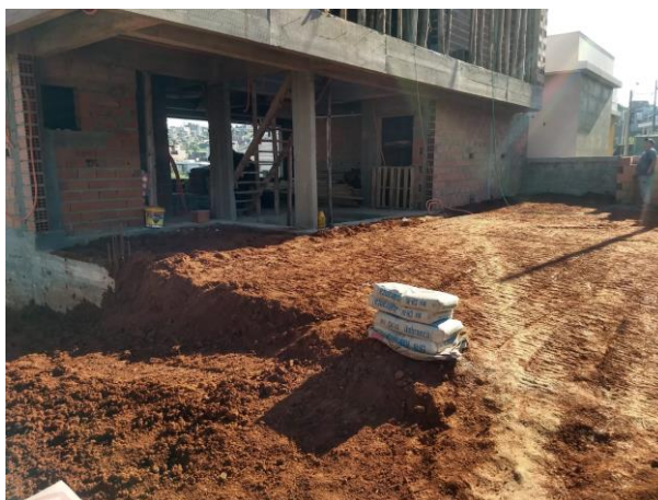
Figura 22 – Canteiro de obras após aterro na frente da casa
