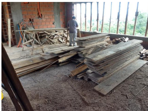
Figura 15 – Marcenaria montada no pav. térreo
