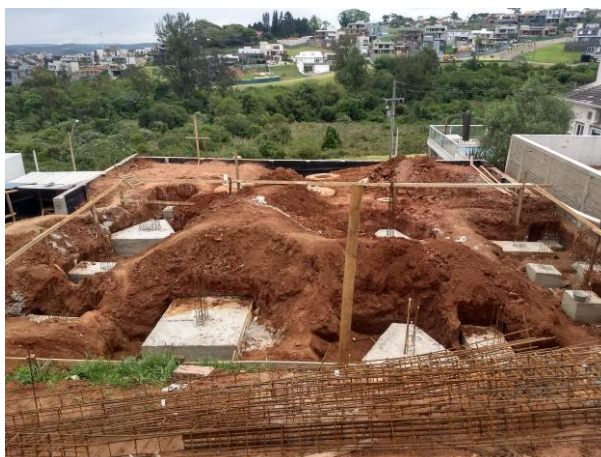
Figura 8 – Execução de blocos de fundação
