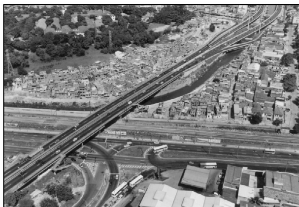
Figura 14 – Interseção com sinalização semafórica
