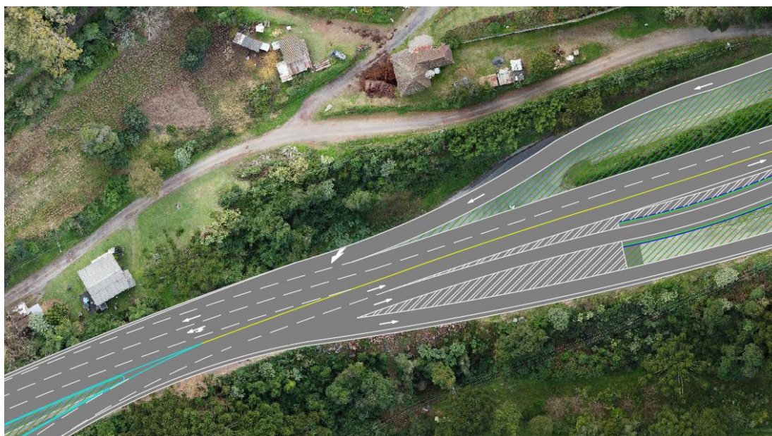
Figura 52 – Detalhe da pista
