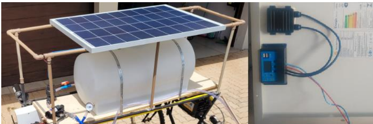
Figura 49 – Montagem da placa fotovoltaica
