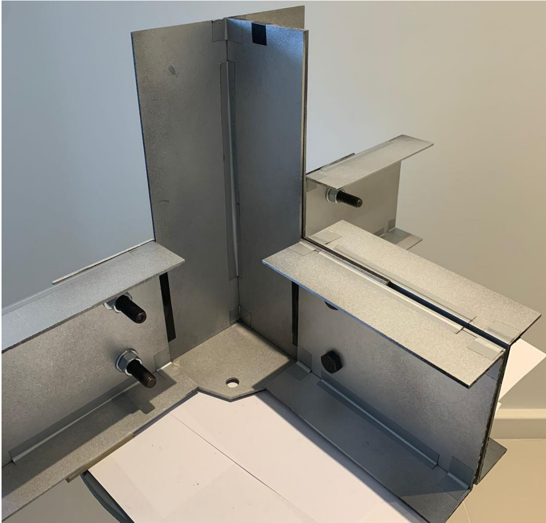
Figura 54 - Modelo Kovel - Detalhe conexão horizontal.
