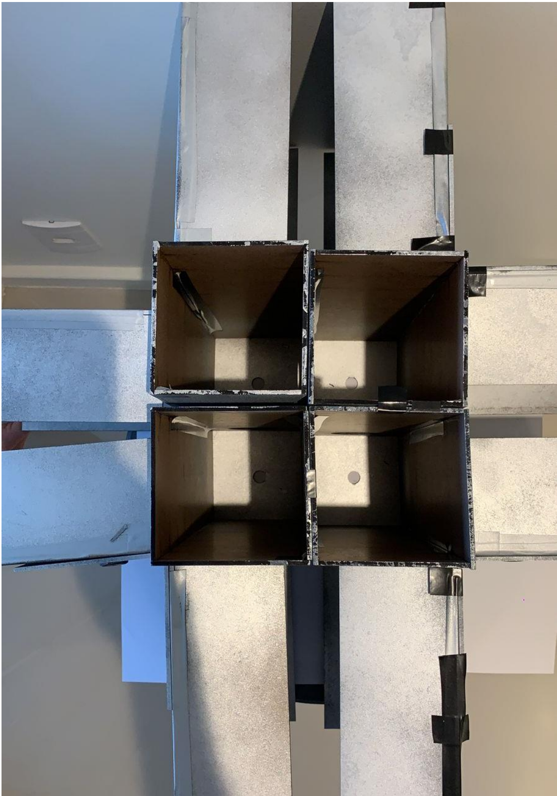
Figura 49 - Modelo Lawson – Detalhe vista de cima de conexão horizontal entre módulos volumétricos.
