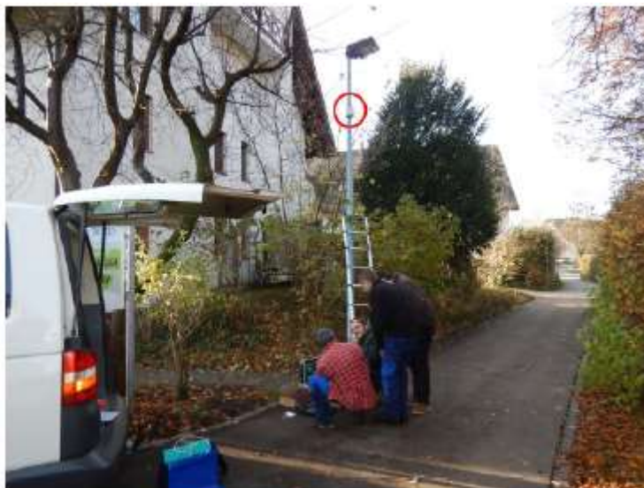
Figura 25 – Dispositivo Repetidor LoRaWAN instalado em poste
