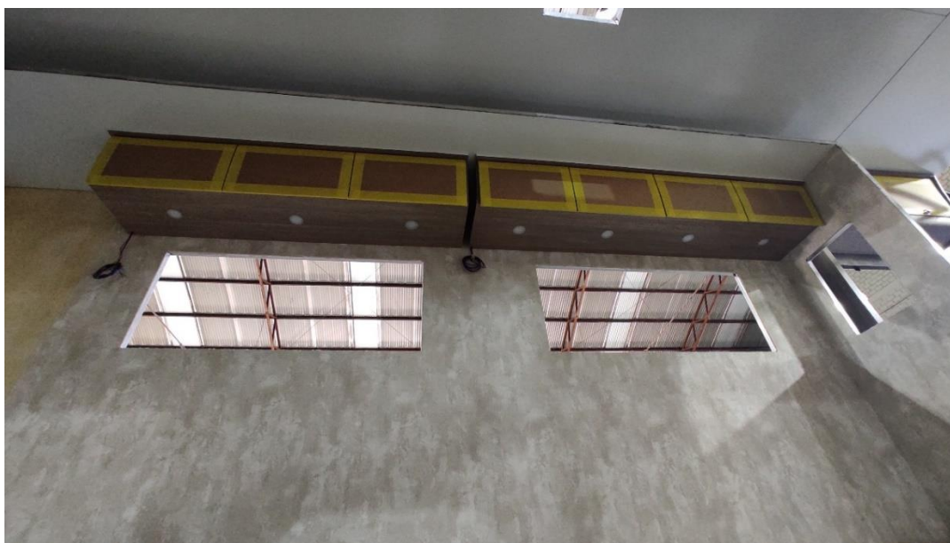
Fotografia 5 – Montagem elétrica no móvel
