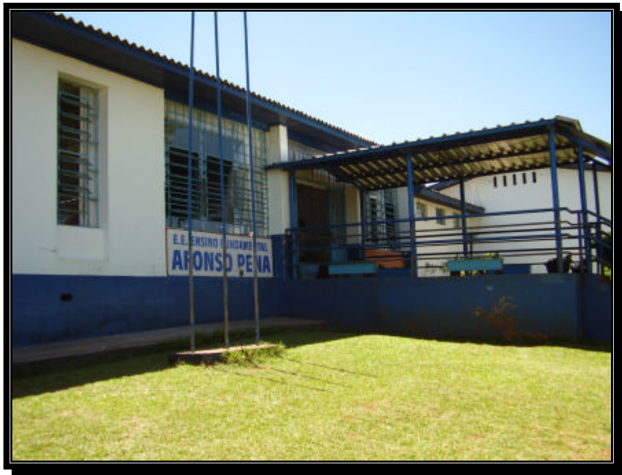
Ilustração 3 - E. E. E. Fundamental Afonso Pena – Entrada Principal.
