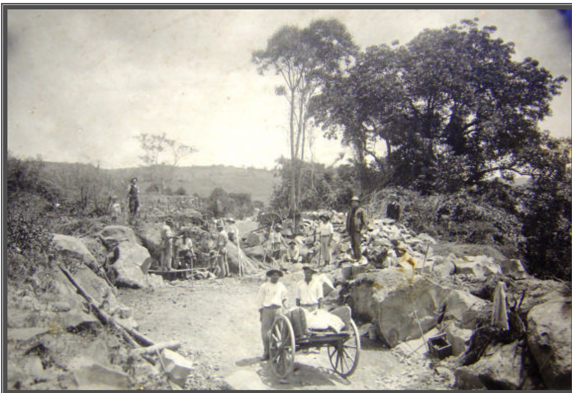
Figura 14 - Abertura e construção de estradas. Fonte: Museu Histórico Casa do Imigrante – Bento Gonçalves.
