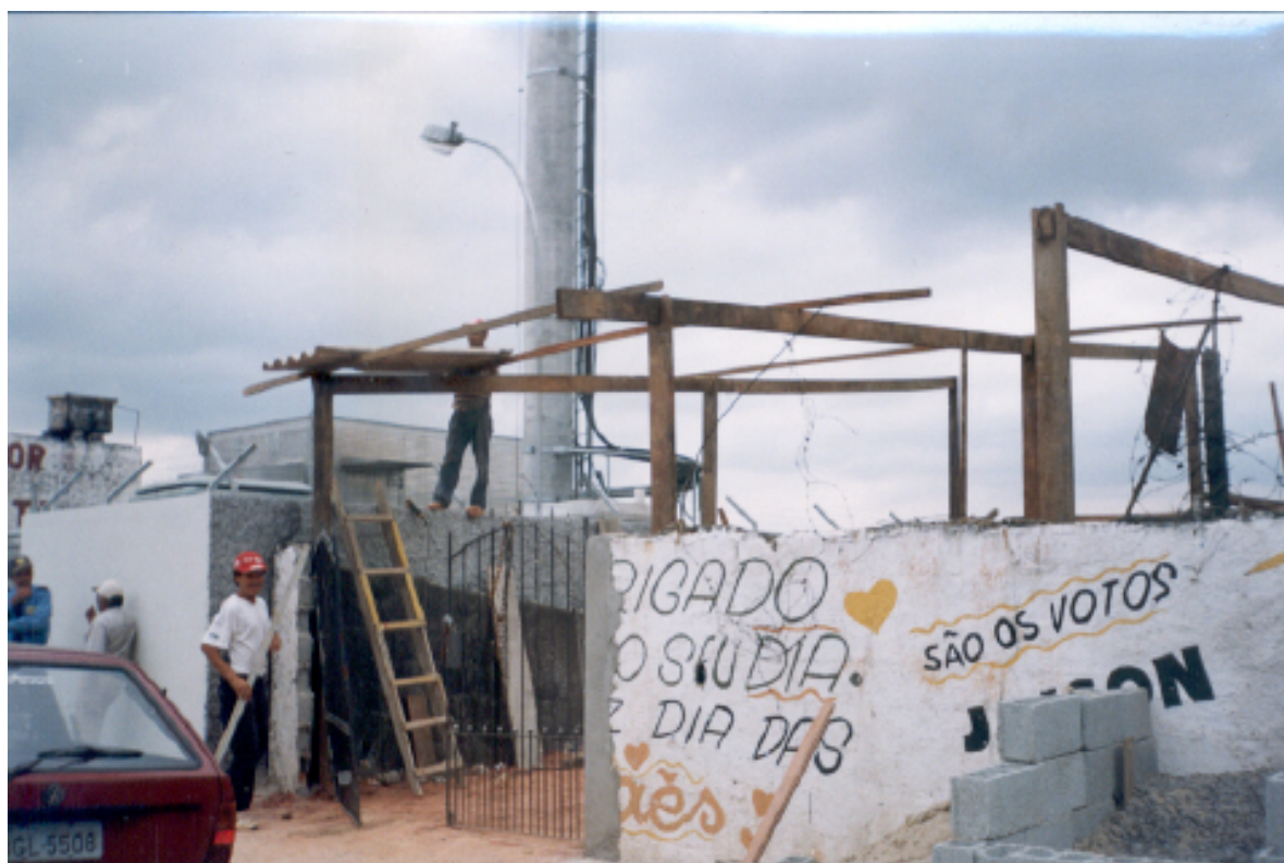
Foto 2 – Trabalhadores da comunidade construindo o espaço usado como sede e galpão de armazenagem.
