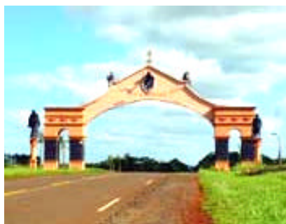
Pórtico de acesso a São Miguel das Missões 146 .
