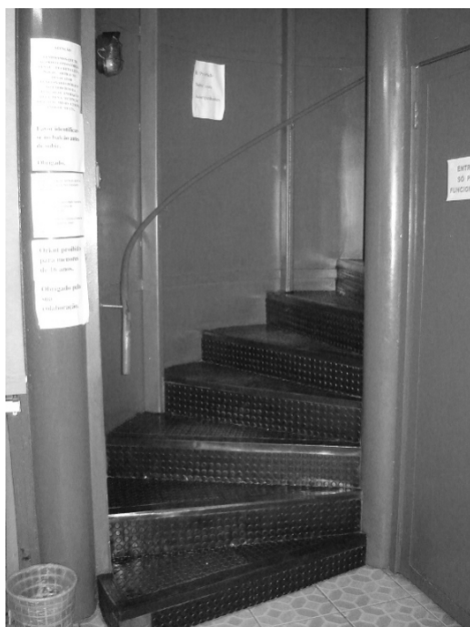
Foto 14 – A Vinholes – Escada de acesso ao mezanino
