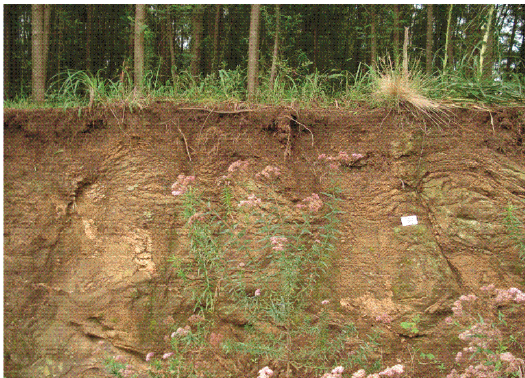
Figura 20: Basalto da Formação Serra Geral, alterado com estruturas de alívio de tensões e esfoliação esferoidal. Localizado a 300 m à sul do P6 (figura 18).
