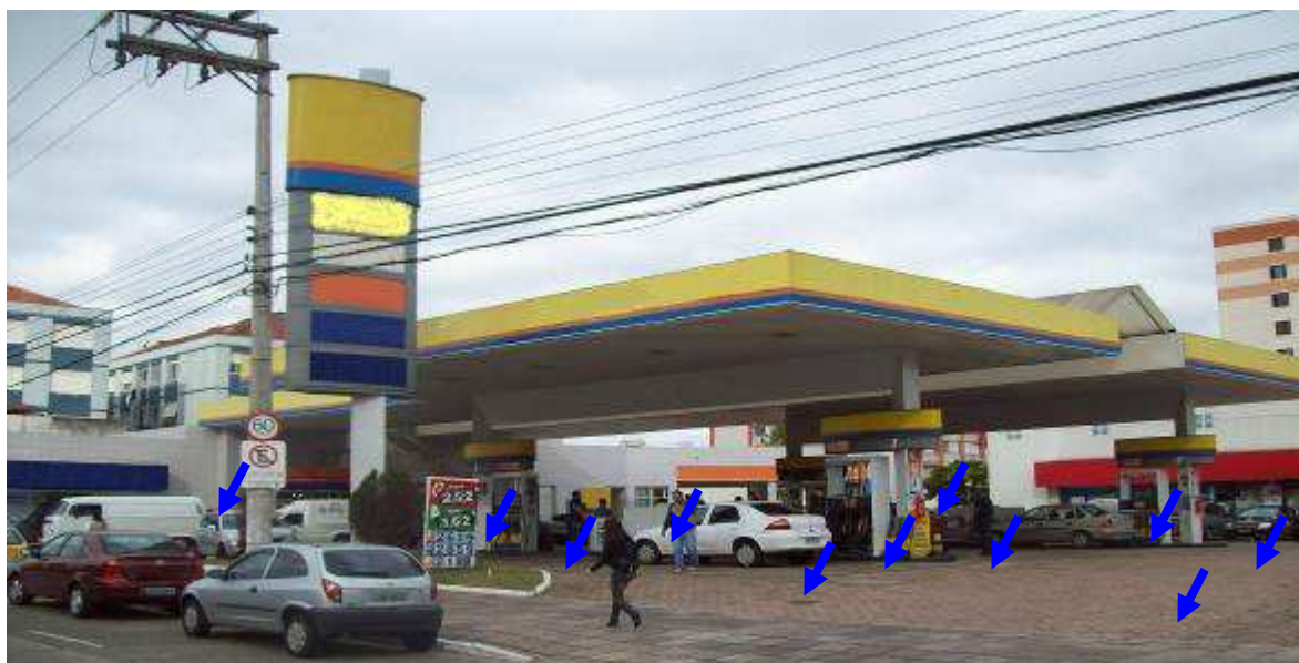
Figura 6 – Posto de abastecimento com identificação dos poços de monitoramento (flechas azuis)
