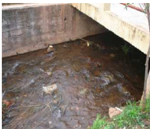
Figura 1 – Corpo receptor sem rejeitos da ETA – Itabirito
