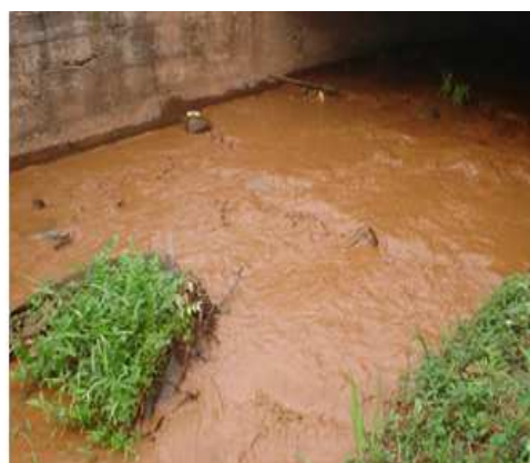
Figura 2 – Corpo receptor com rejeitos da ETA – Itabirito
