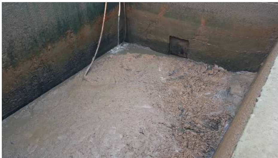
Figura 17 – LETA em tanque de decantação
