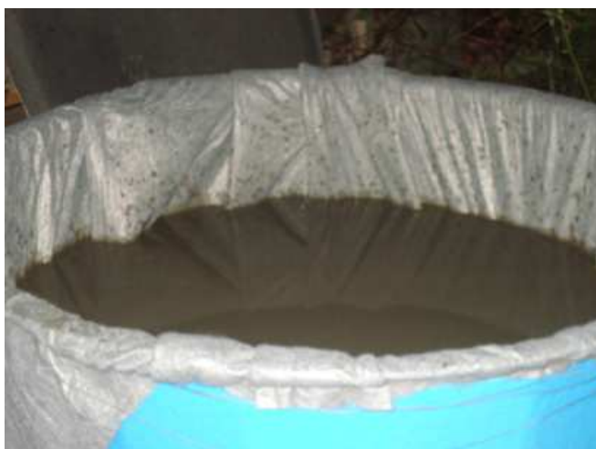
Figura 7 – Unidade de desaguamento utilizando manta
