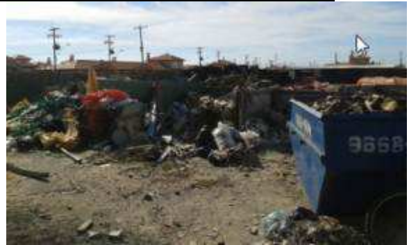
Figura 9: Depósito de resíduos sólidos sem separação por tipo, sem estar abrigado de intempéries e sem identificação.
