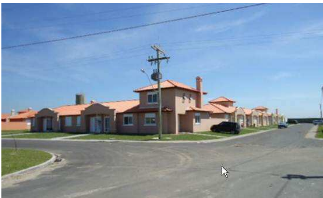
Figura 5: Vista de uma quadra da obra A
