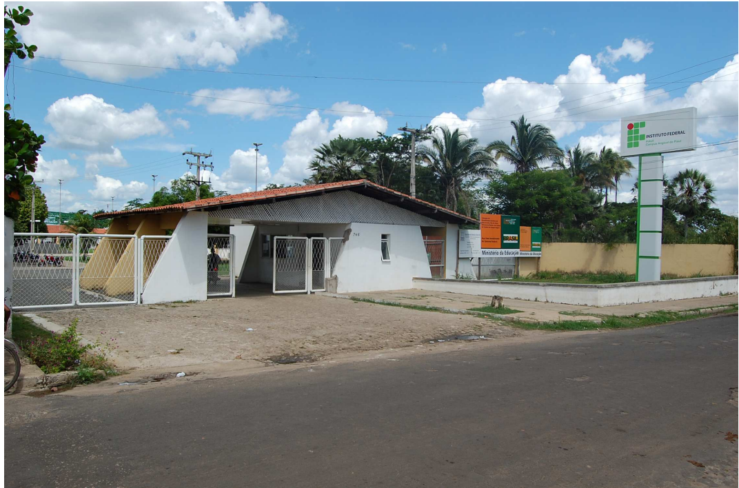
Figura 14: Fachada principal IFPI-Angical do Piauí Fonte: Assessoria de Comunicação/IFPI - 2013
