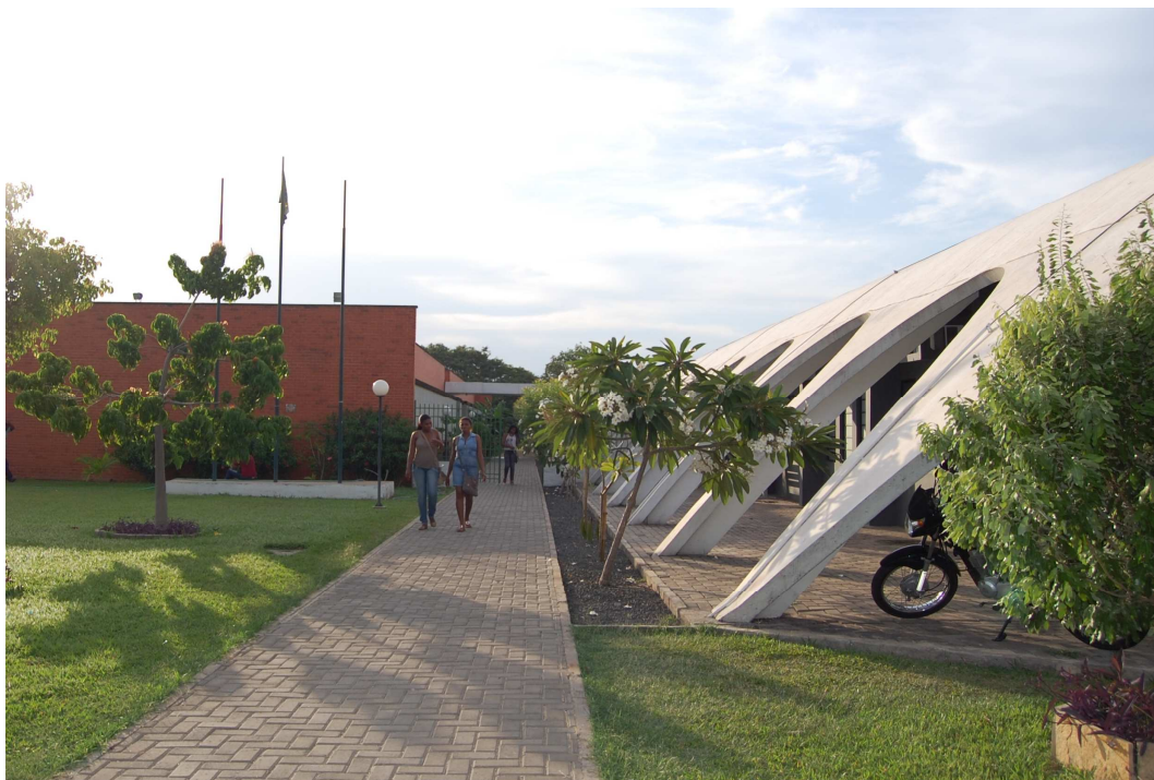
Figura 13: Fachada principal IFPI-Teresina Zona Sul Fonte: Assessoria de Comunicação/IFPI - 2013
