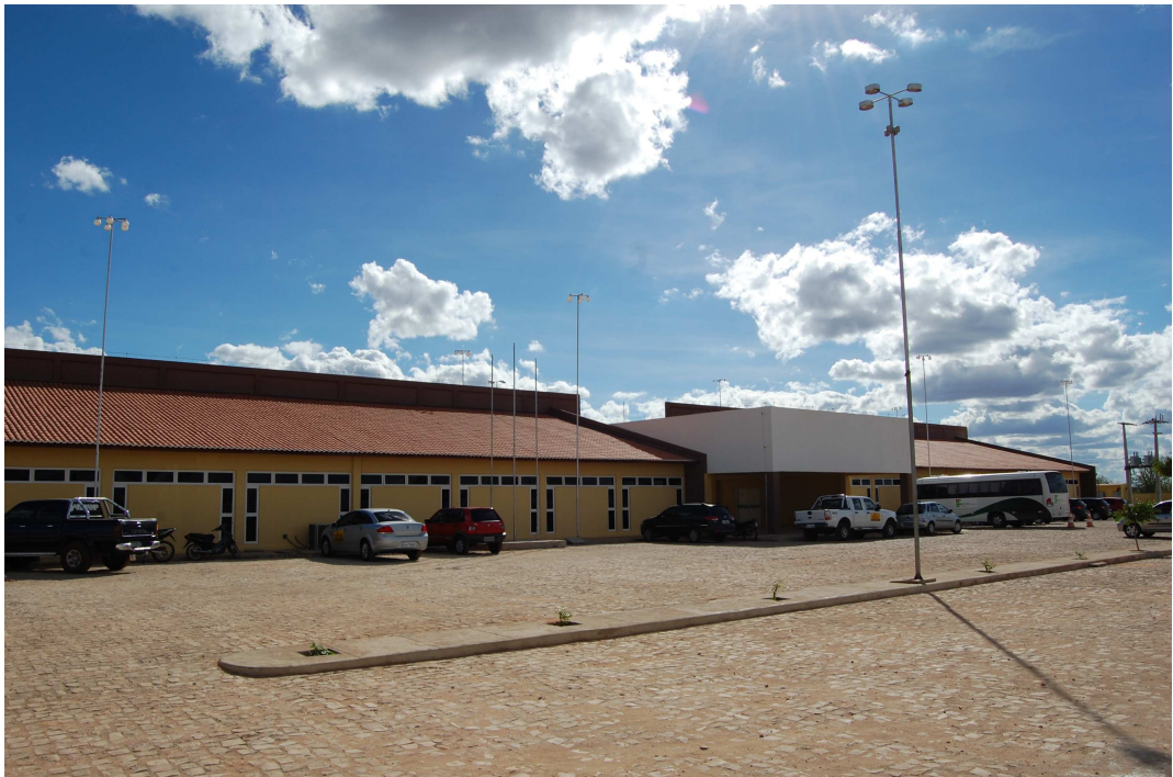
Figura 18: Fachada principal IFPI-Paulistana Fonte: Assessoria de Comunicação/IFPI - 2013
