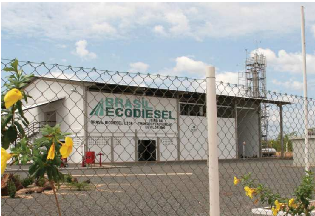
Figura 23: Usina de Biodiesel - Floriano/PI Fonte: CODEVASP – 2006
