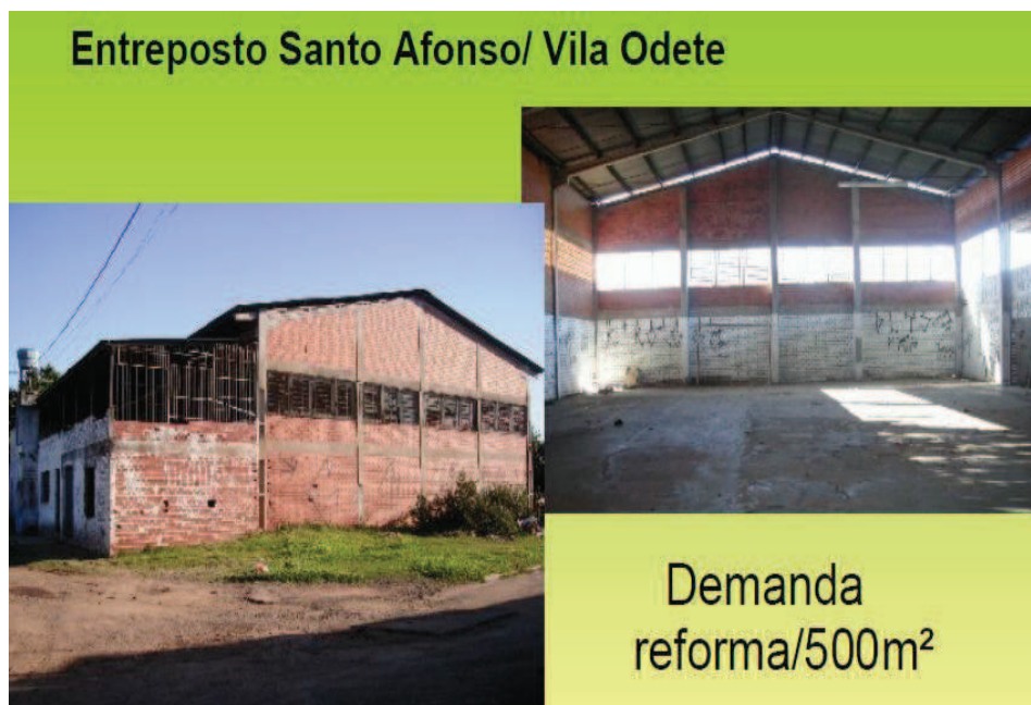
Figura 14: Novas instalações para facilitar estocagem.
