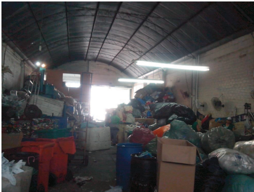
Figura 37: Galpão centro - dos fundos para a entrada - Prensa a esquerda da foto e esteira a direita.
