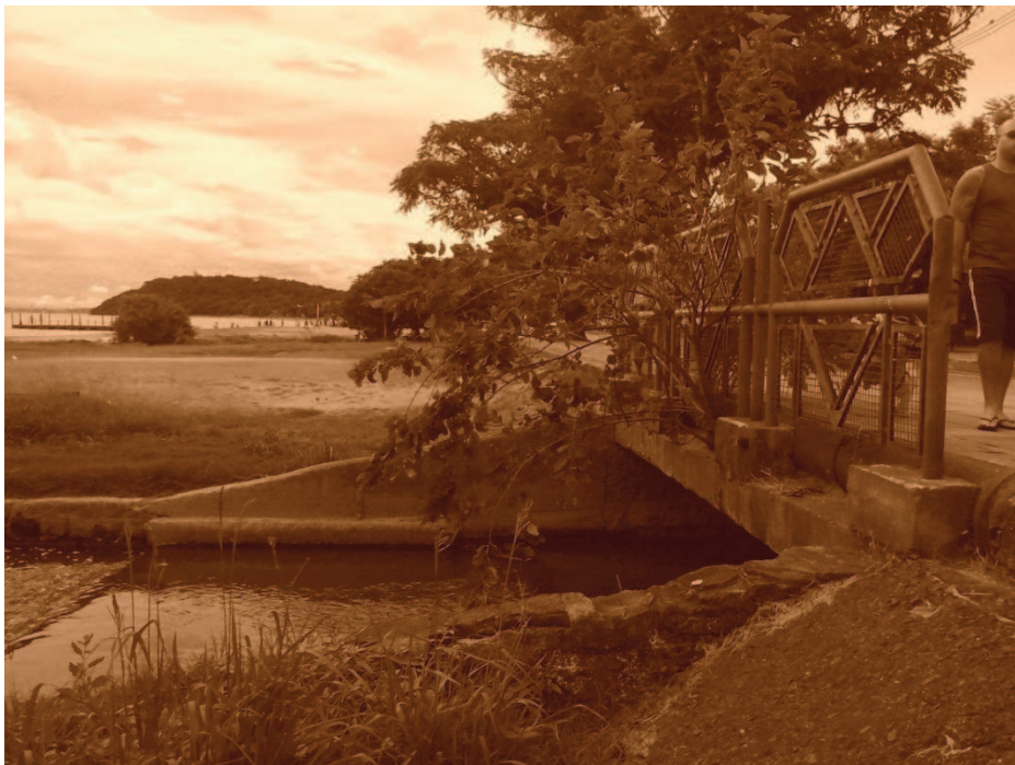
Figura 1: Córrego pluvial. Calçada de Ipanema Porto Alegre
