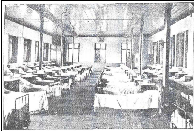
Figura 7 – Dormitório da 1ª Divisão do Colégio Conceição.
