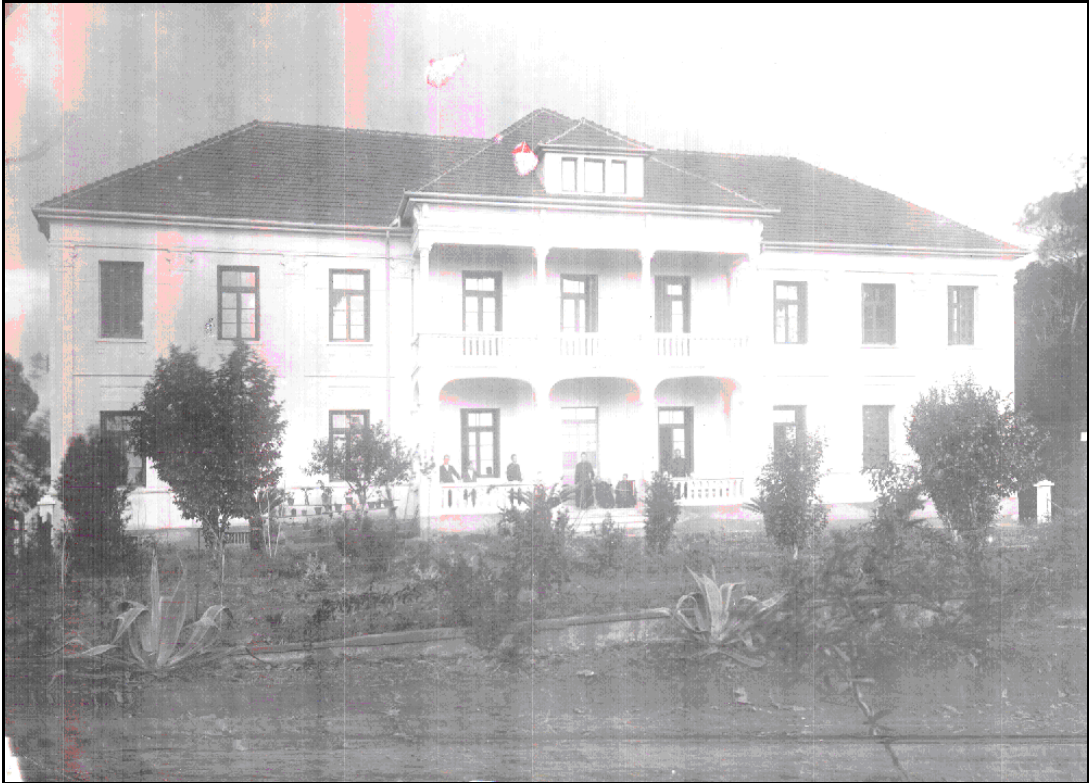
Figura 10 – Vila Gonzaga – Prédio principal da Chácara do Colégio Nossa Senhora da Conceição.
