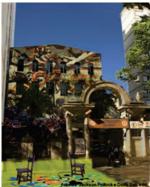
Figura 33: local de Interferência: Estacionamento RG Park - Rua dos Andradas - edifício histórico inutilizado e com necessidade de restauro.
