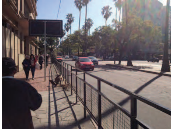
Fotografia 9 – Gradis de proteção
