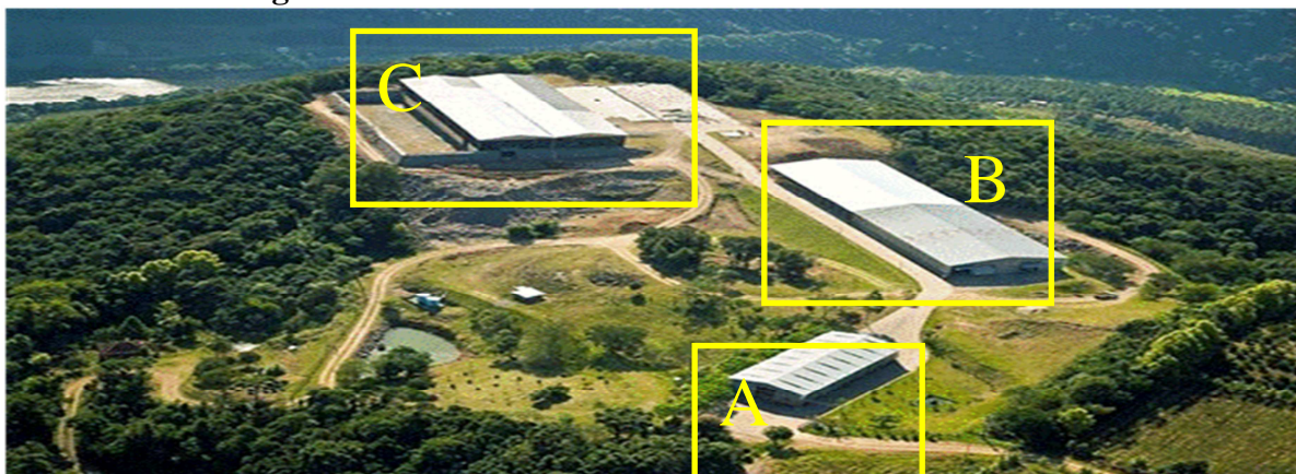
Figura 11 – Vista aérea do Aterro Industrial da Proamb
