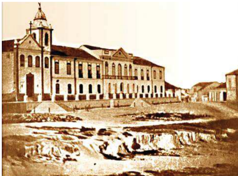
Imagem 4: Santa Casa de Porto Alegre, tendo ao lado a Capela Senhor dos Passos. Ano: ca. 1860.
