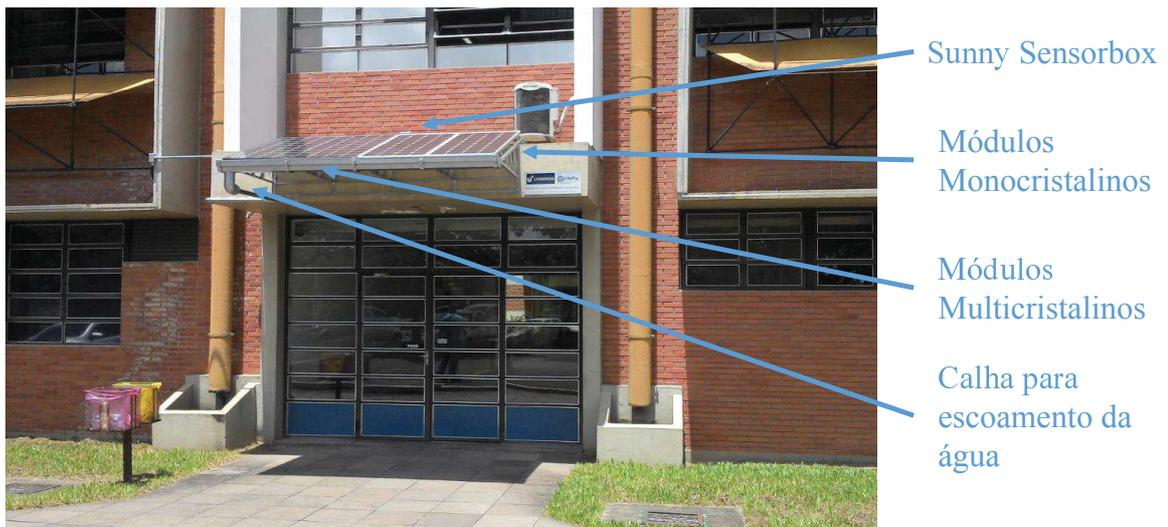
Figura 4.7 - Módulos instalados.
