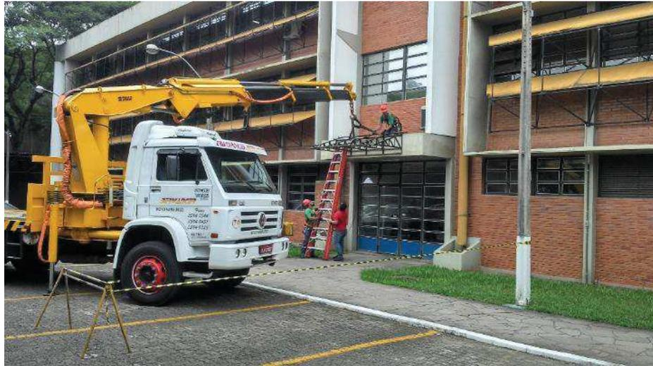
Figura 4.6 - Instalação da estrutura de suporte dos módulos.
