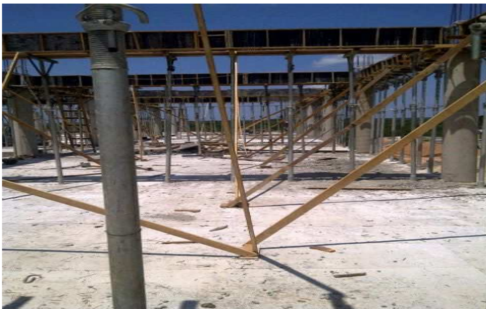
Figura 25: “Laboratórios em construção da futura sede do IINN-ELS, gerido pela AASDAP, no Campus do Cérebro!” 113 .
