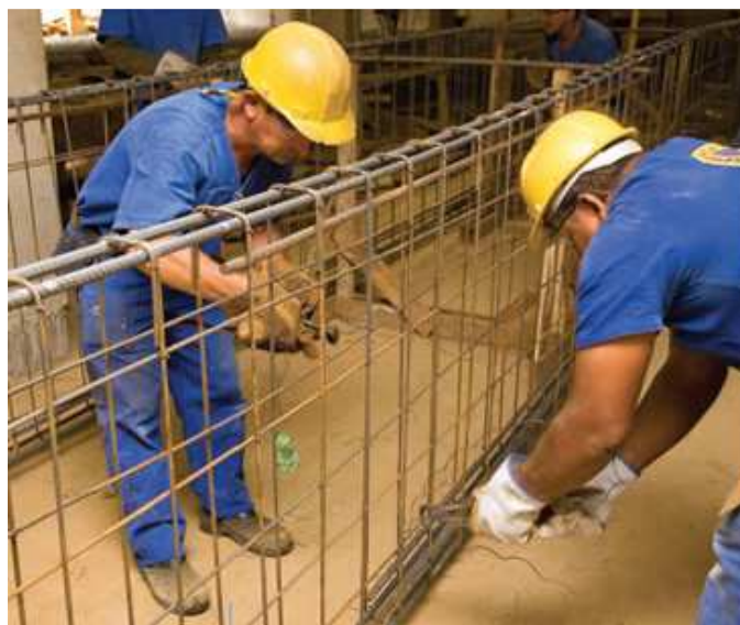
Figura 13 - Amarração de estruturas – viga de sustentação.
