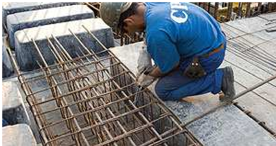
Figura 12 - Amarração de estruturas – sapata.
