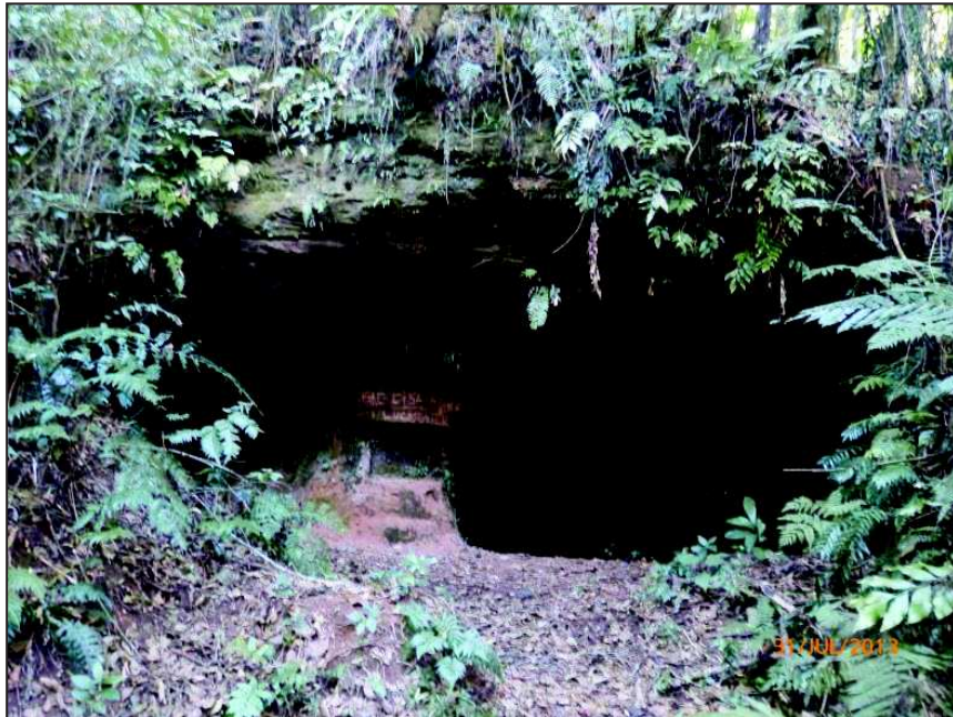
Figura 13: Entrada principal, que apresenta degradação advinda do processo histórico de ocupação em conjunto com atividades hídricas naturais. Fonte: Autor.
