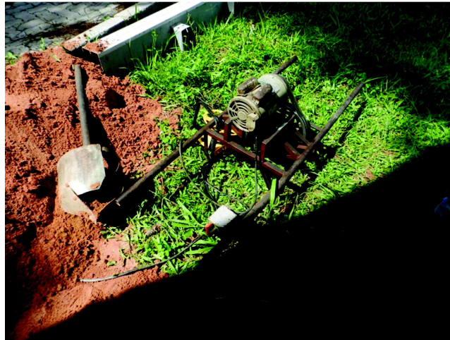
Figura 3.3: Perfuratriz manual utilizada para perfuração do solo.
