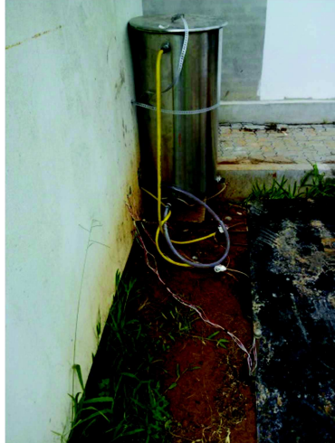
Figura 3.7: Reservatório térmico para o controle da temperatura da água de alimentação do trocador de calor.
