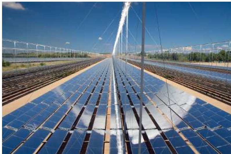
Figura 2.4 Sistema de refletores lineares Fresnel (FLR). Fonte: Novatec (2015).
