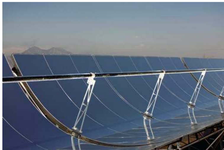
Figura 2.3 Concentradores tipo calha parabólica instalados no deserto de Mojave, na Califórnia (CPC). Fonte: Cifes (2015).
