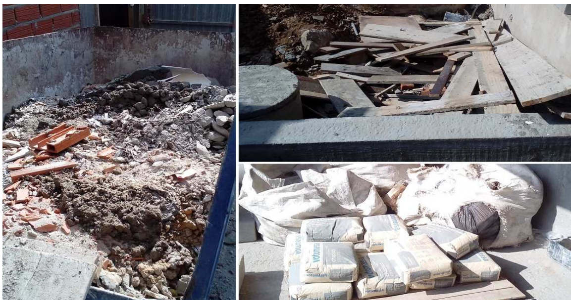
Figura 5 – Resíduos de Classes A, B e C presentes no Edifício B
