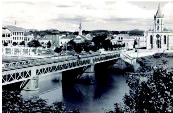
Figura 3- Ponte 25 de Julho no Centro Histórico de São Leopoldo
