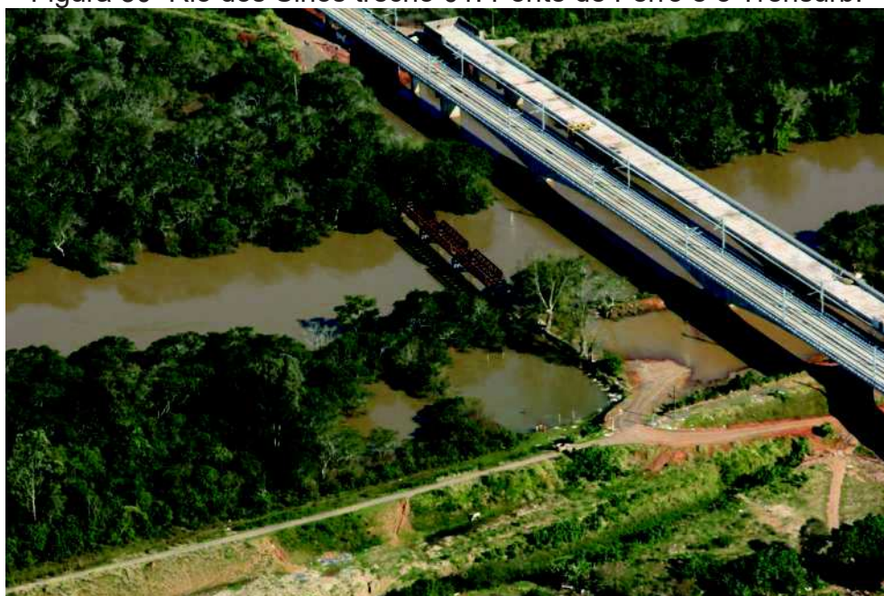
Figura 30–Rio dos Sinos trecho 01: Ponte de Ferro e o Trensurb.
