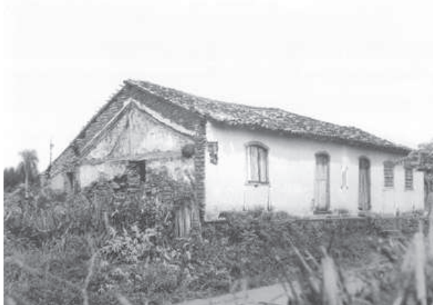
Figura 6- Casa da Feitoria antes da reforma
