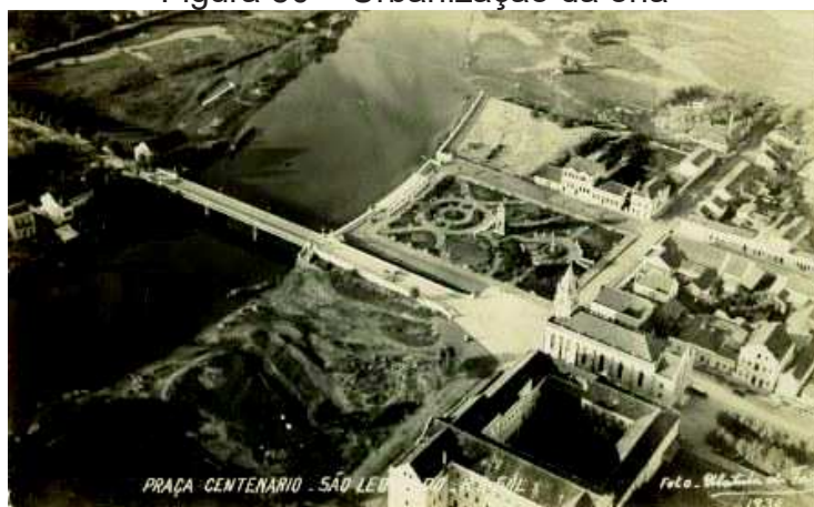
Figura 50 – Urbanização da orla
