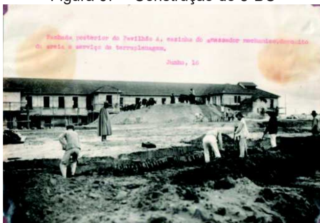
Figura 67 – Construção do 8ºBC
