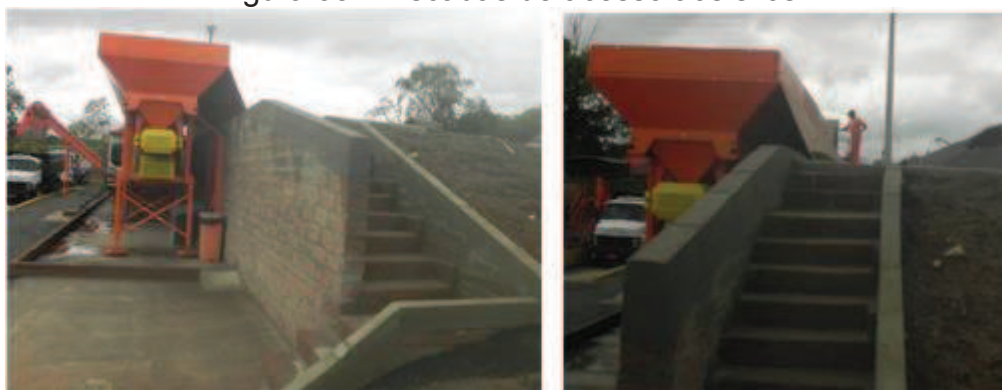
Figura 35 – Escadas de acesso aos silos.
