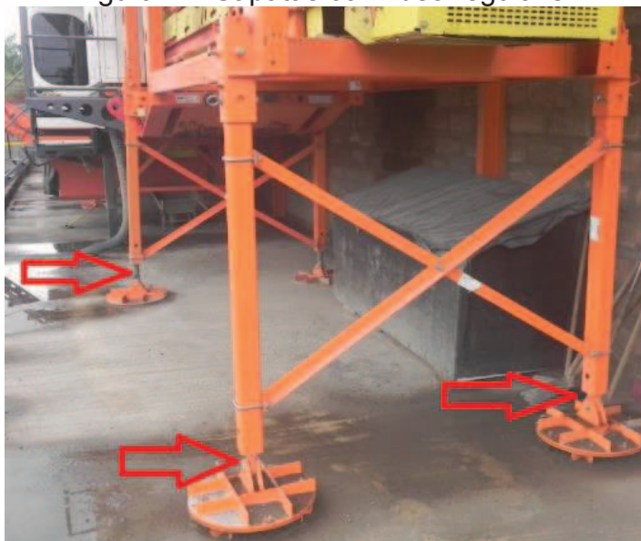
Figura 7 – Sapatas com fuso regulável.
