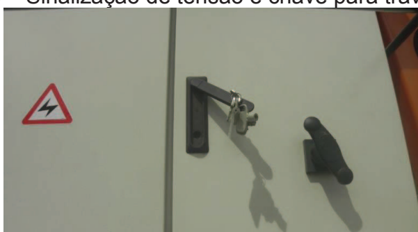
Figura 13 – Sinalização de tensão e chave para travar a porta.
