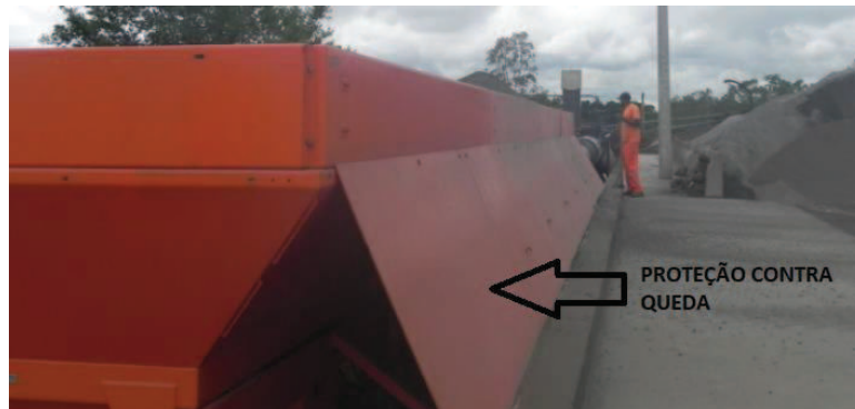
Figura 23 – Proteção contra queda.
