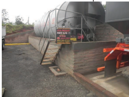
Figura 6 – Muro de arrimo nos tanques e combustíveis.
