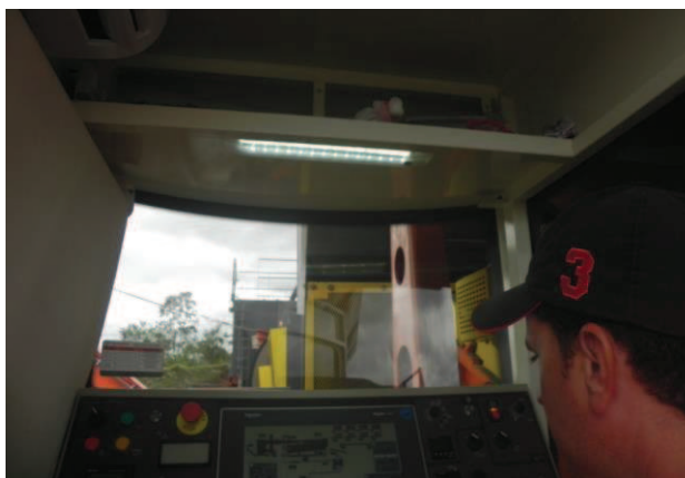
Figura 44 – Iluminação da cabine.
