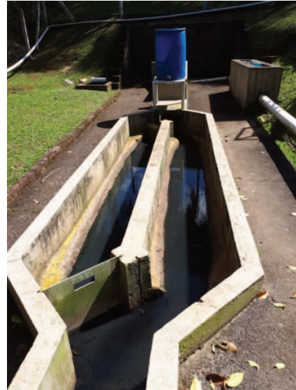
Fotografia 2 - Caixa de areia para a remoção de areia através da sedimentação
