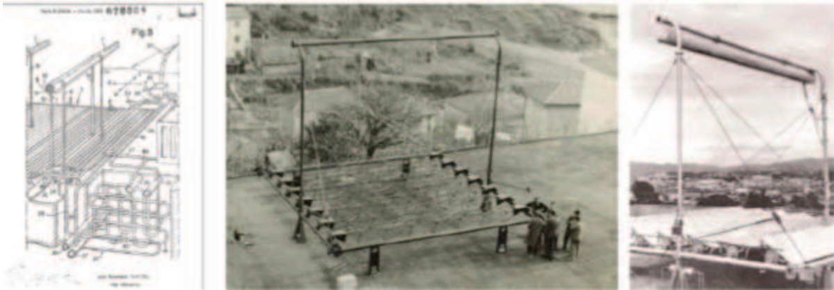
Figura 3.4 - Protótipo um refletor Fresnel linear, construído por Francia, em 1964.
