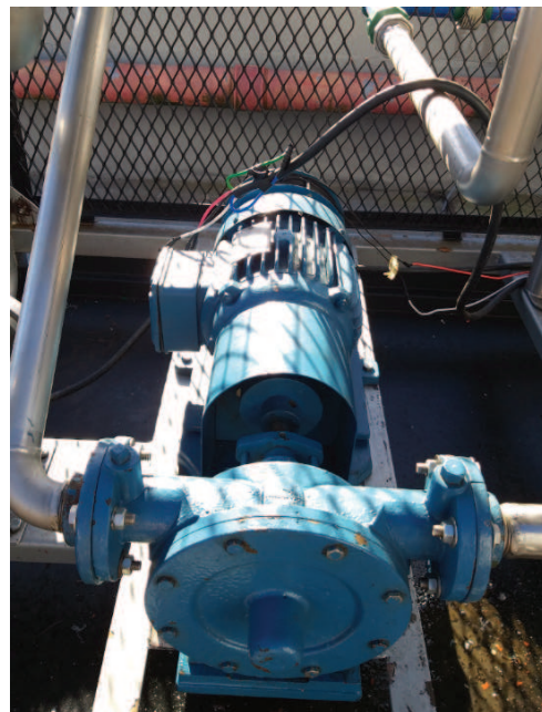
(b) Motor de indução e bomba
