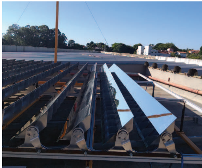
Figura 6.6 - Fileiras de espelhos instalados através da estrutura de sustentação.
