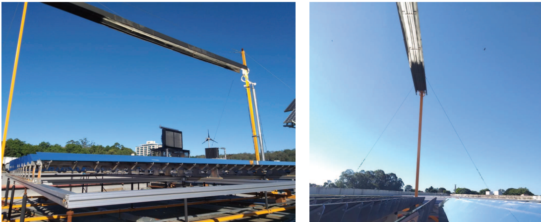
Figura 7.12 –Parte do absorvedor não iluminado pela radiação refletida pelos espelhos no dia 09 de abril.
