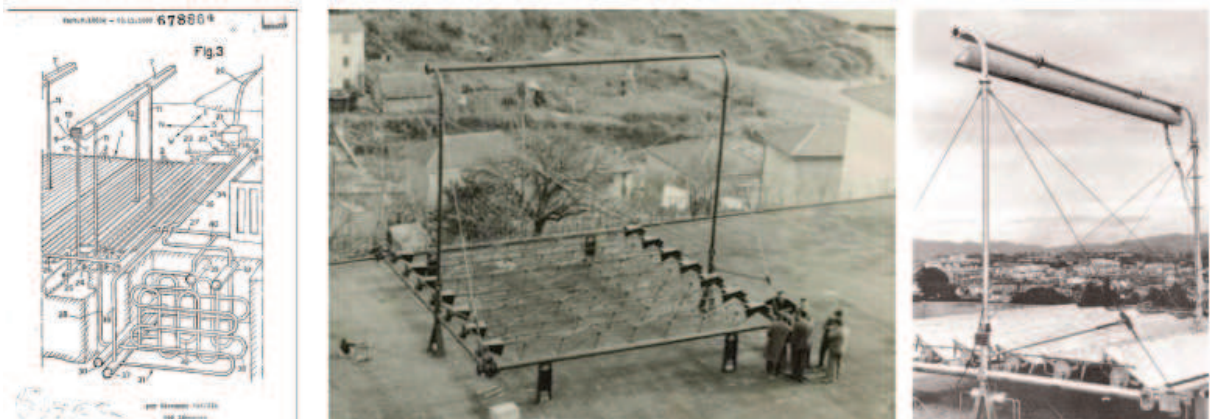
Figura 2.11 - Desenho do refletor Fresnel patenteado e fotos do primeiro protótipo.
